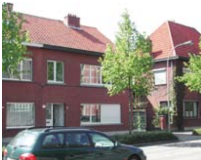
Het laatst aangekochte huis aan de Augustijnslei te Brasschaat is opgeknapt. De eerste bewoners trokken in juni in hun woning.
